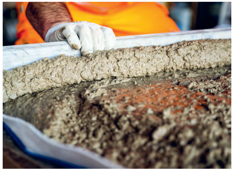
Bauarbeiter taloschieren die Oberfläche, damit sie glatt wird.
