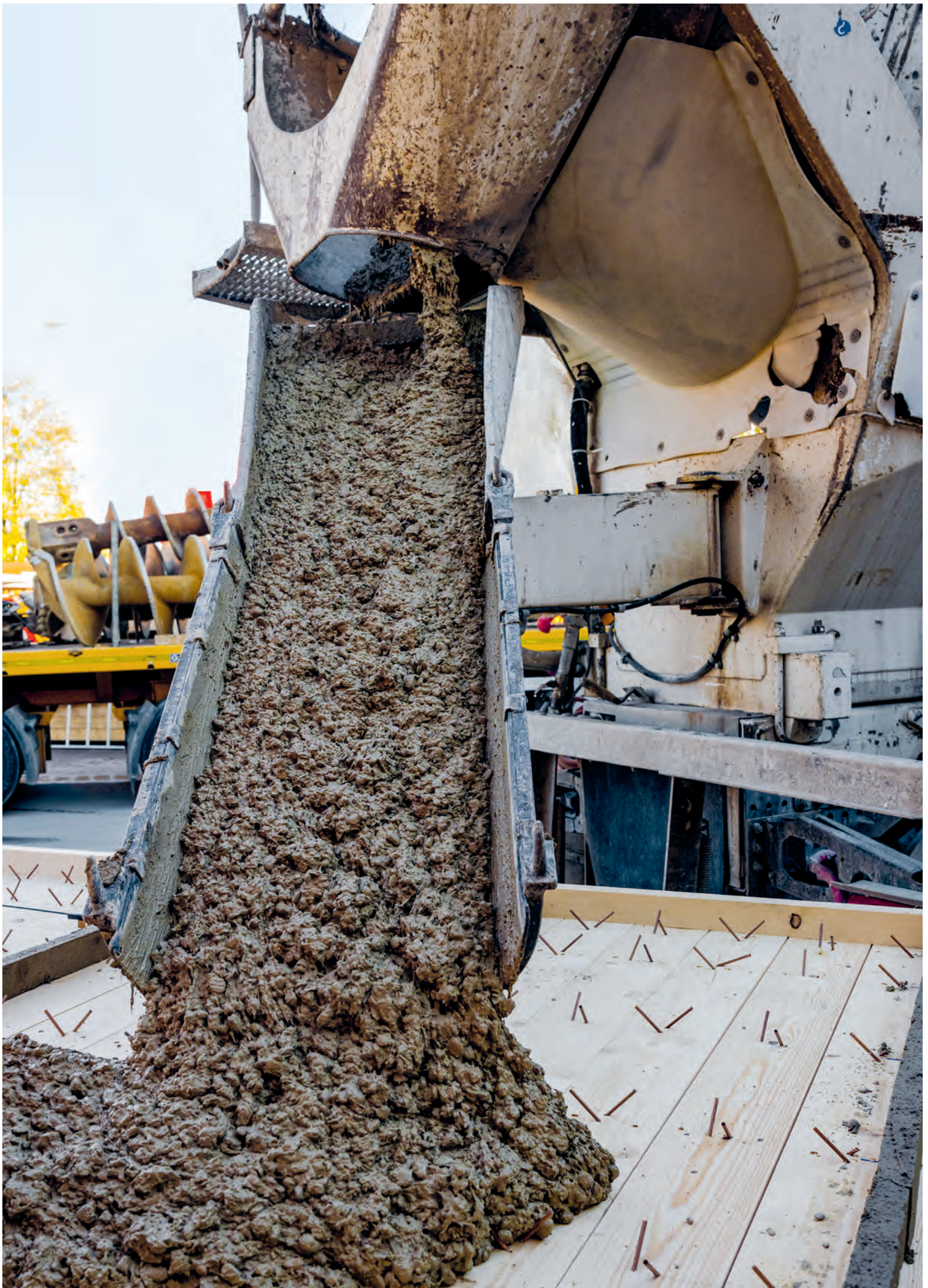
Der Flüssiglehm wird wie Beton in eine Schalung gegossen, wo er aushärtet.
