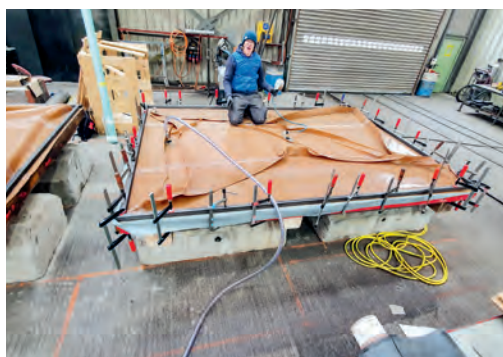
Eine Vakuumpumpe entzieht dem Lehm die Feuchtigkeit.
