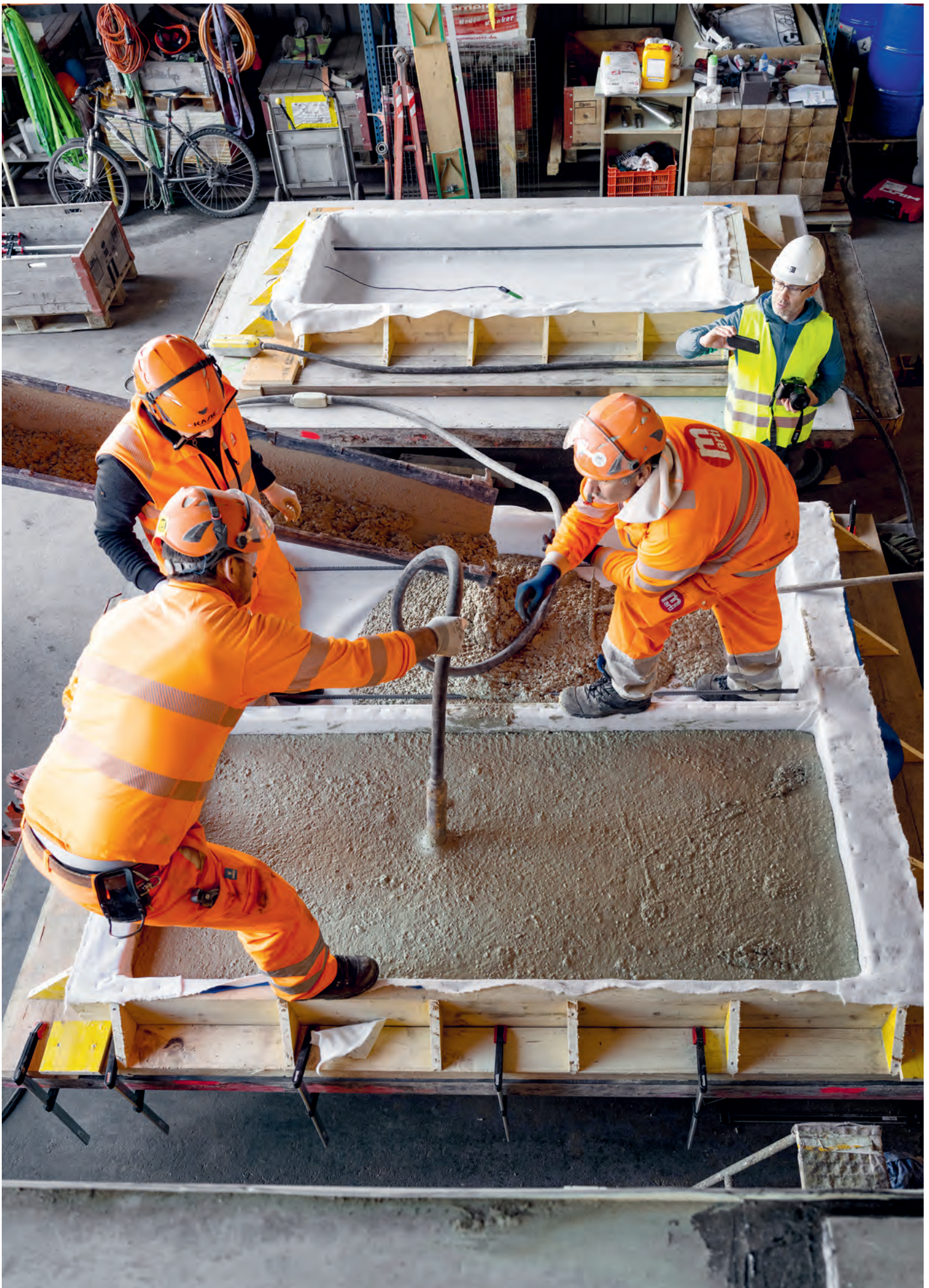
Die Bauarbeiter verteilen den Flüssiglehm mit einem Rechen und tauchen eine Vibriernadel in die Masse.
